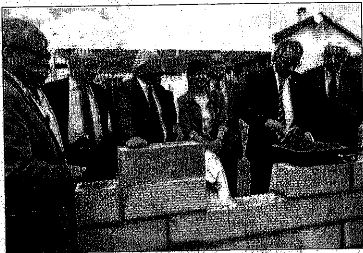
Au chantier du nouveau bassin, les autorités ont montré leur savoir-faire à la truelle
